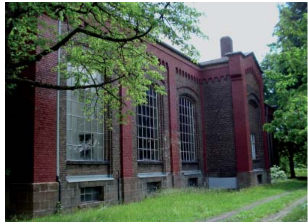
Abb. 1: Pumpstation Haan vor der Modernisierung
