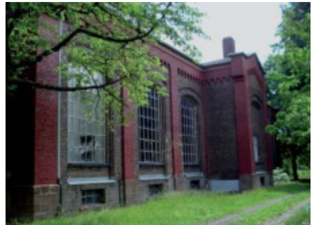
Abb. 1: Pumpstation Haan vor der Modernisierung
